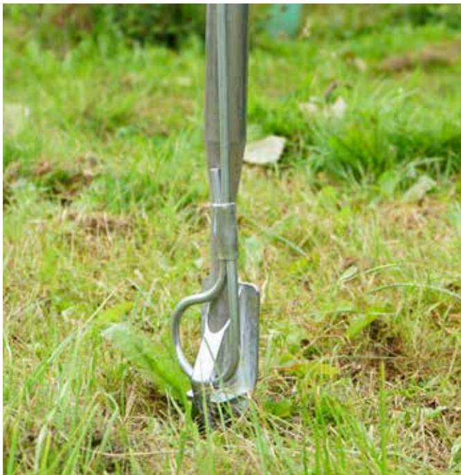
APEX 3 mit Stabspannglied wird in den Boden getrieben
