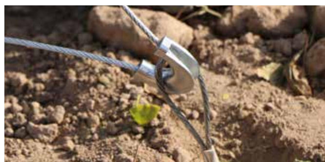
Oben ; Installierte Apex Anker Unten : Schlaufe mit Drahtseil
