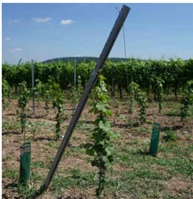
APAK Plus M an Metallpfählen installiert
